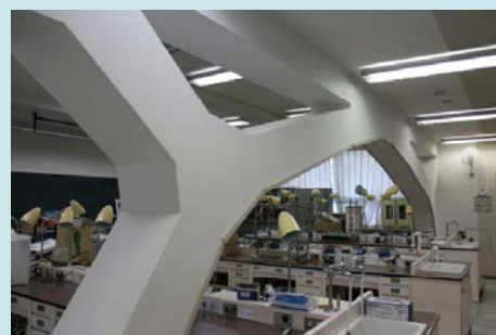
施設設備の整備（耐震工事）
